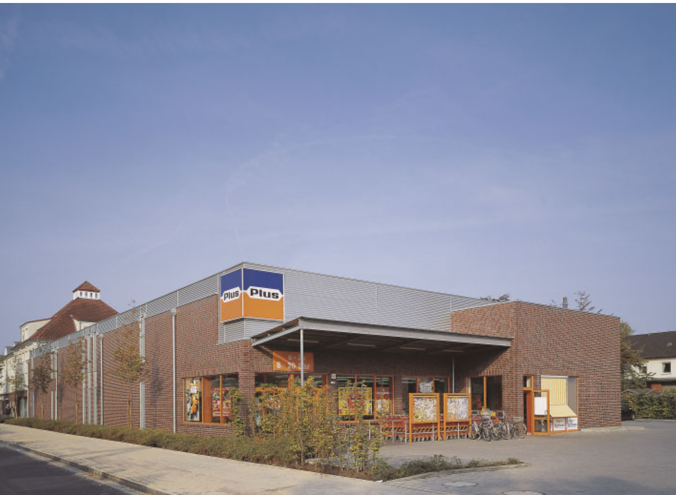
Plus-Markt | Carl-Bertelsmann-Straße 75 Architektur- und Ingenieurbüro Hans-Gerd Jansen | Paderborn
