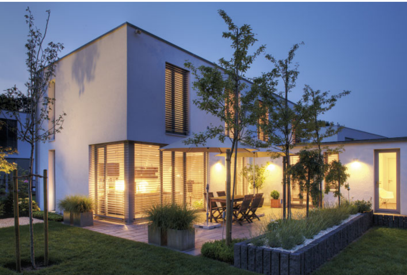
Hausgruppe | Julie-Puwelle-Straße 10 Schróder & Gaisendrees Architekten-Ingenieure | Gütersloh
