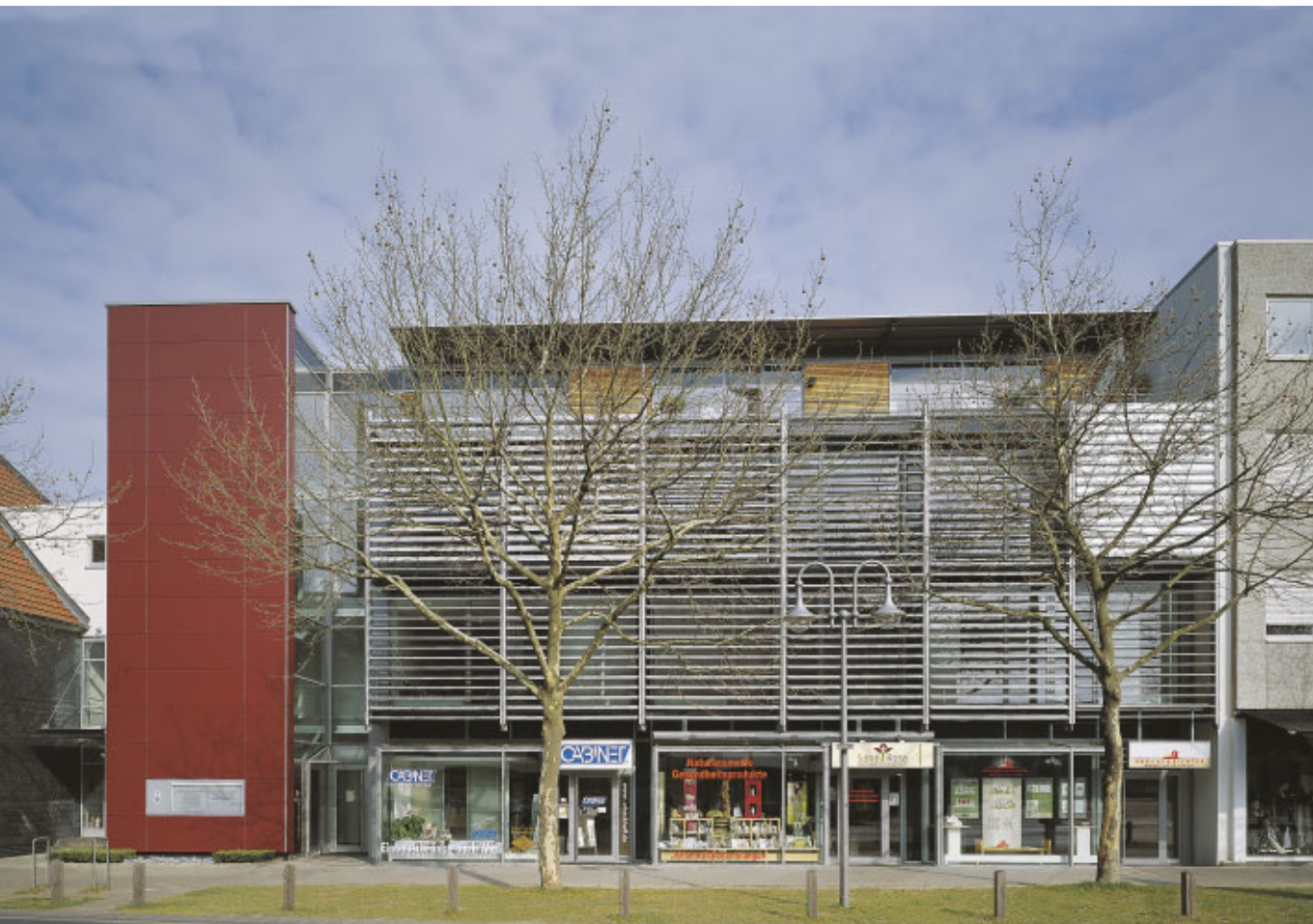
Wohn- und Geschäftshaus | Blessenstätte 8 ehw architekten Hüske · Holtkamp-Eckhardt · Ruschke | Bielefeld
