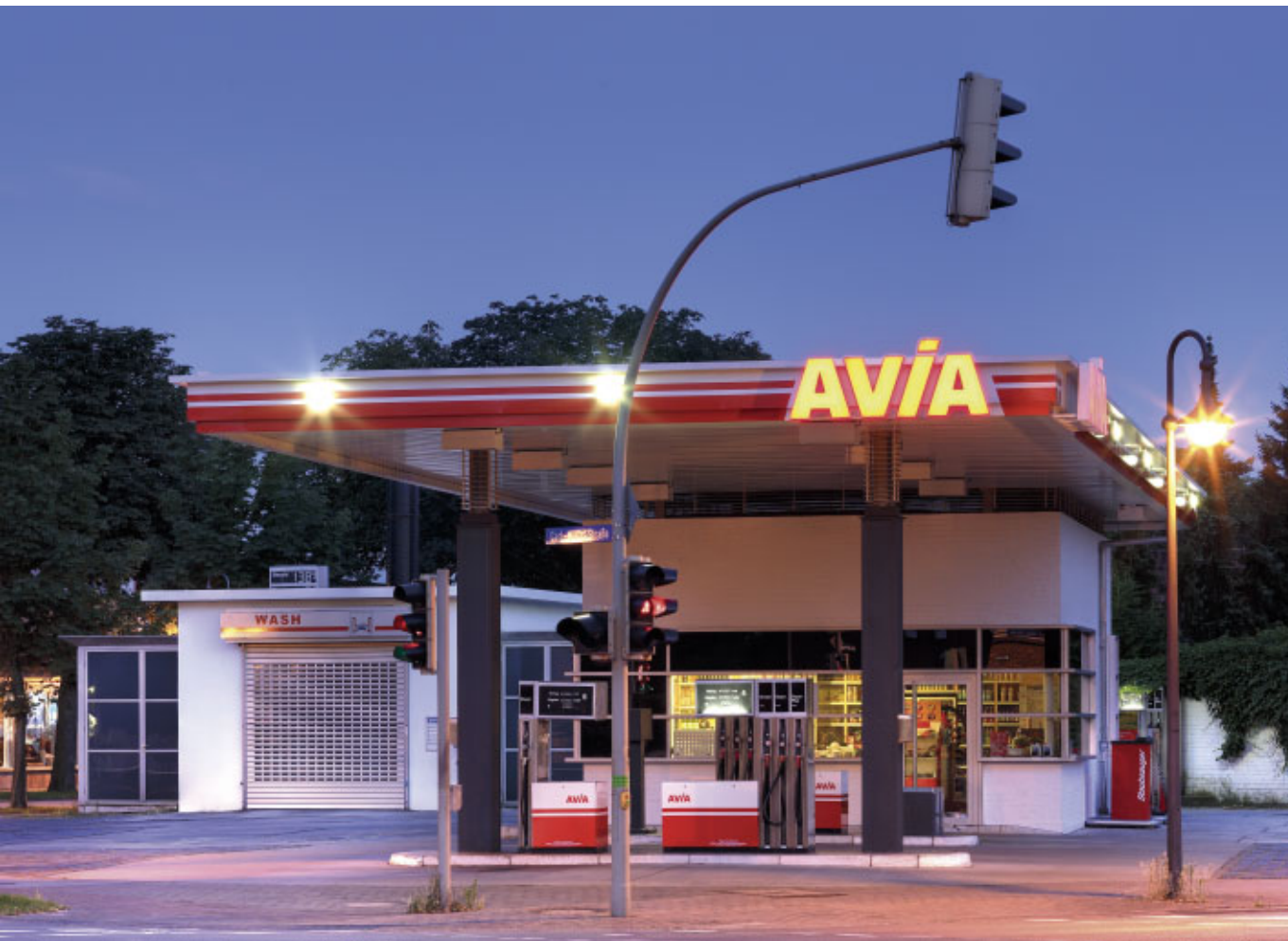
Umbau und Sanierung einer historischen Tankstelle (Baujahr 1927) | Berliner Straße 148 Schröder & Gaisendrees Architekten-Ingenieure | Gütersloh
