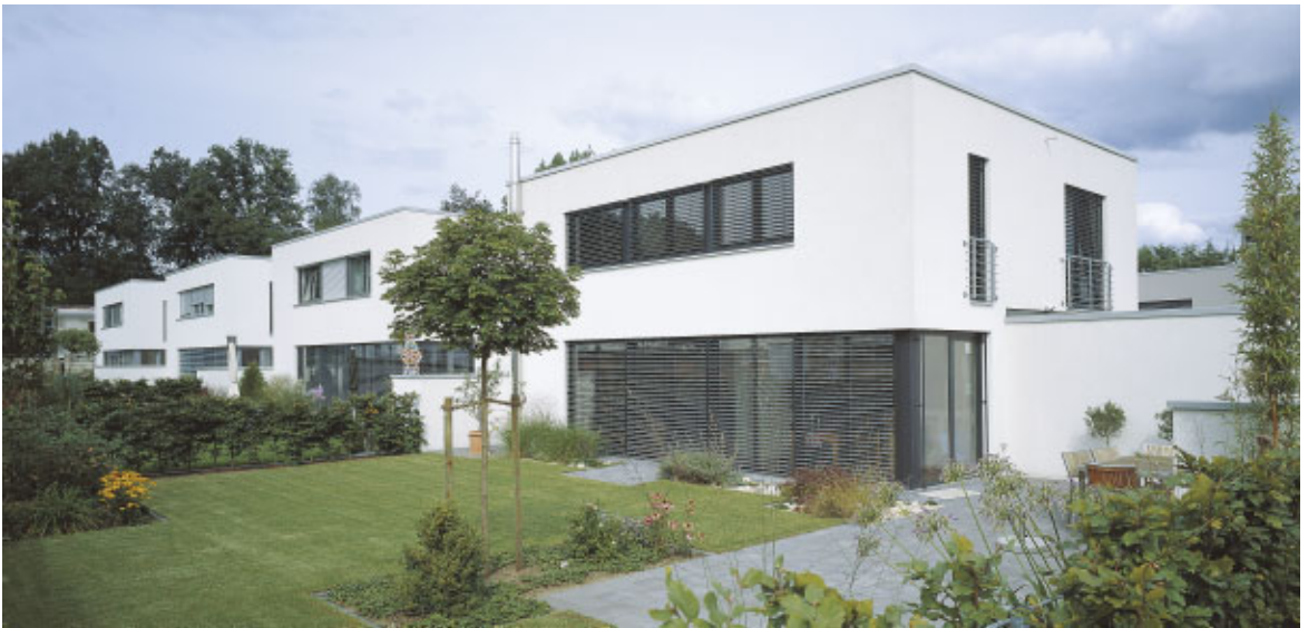
Wohngruppe | Erna-Diekmann-Straße 4-10 Architekt Joachim Rabeneck | Rietberg
