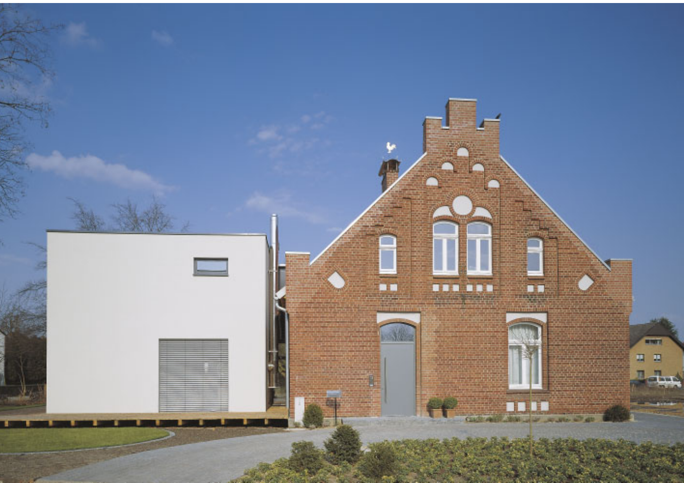
Erweiterung, Sanierung und Umnutzung einer Kleinkinderschule zum Wohnhaus | Grüne Straße 13
