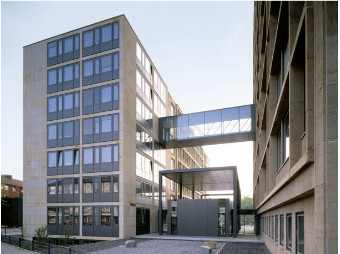
An- und Verbindungsbau Rathaus Gütersloh | Berliner Straße 70 Hauer & Kortemeier Dipl.-Ing. Architekten BDA | Gütersloh
