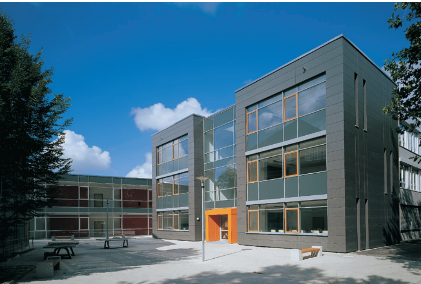
Erweiterung des Städtischen Gymnasiums | Schulstraße 18 Herzog & Kordtomeikel Architekturbüro | Gütersloh
