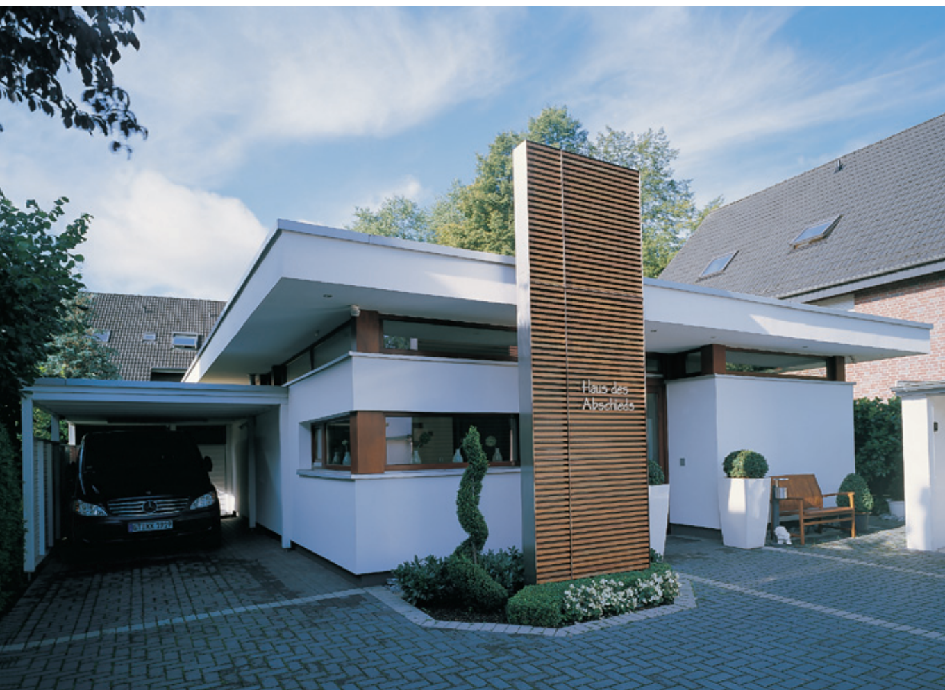
»Haus des Abschieds« | Schalückstraße 10 Axel Zumbansen architekten bda | Gütersloh
