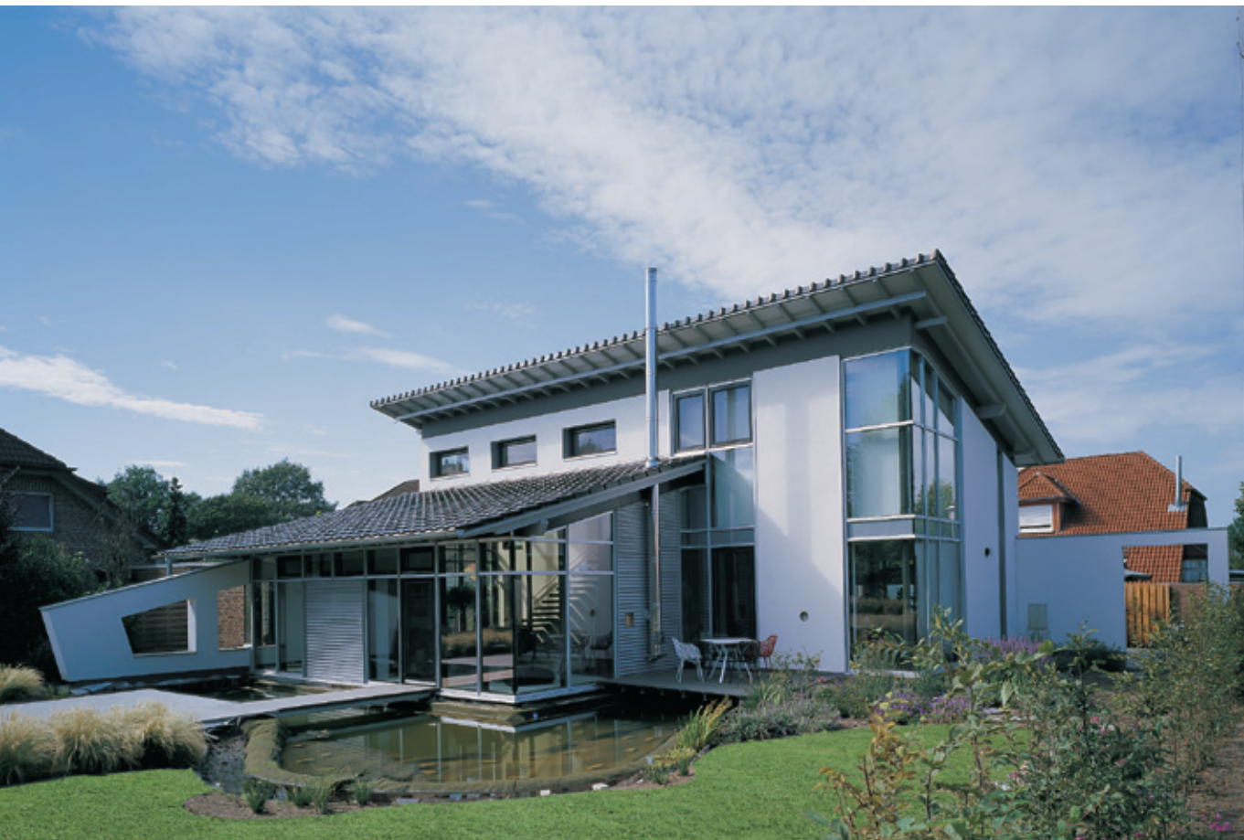
Einfamilienwohnhaus | Erzgebirgsstraße 24 mertens + kirchhoff Architektengemeinschaft | Gütersloh
