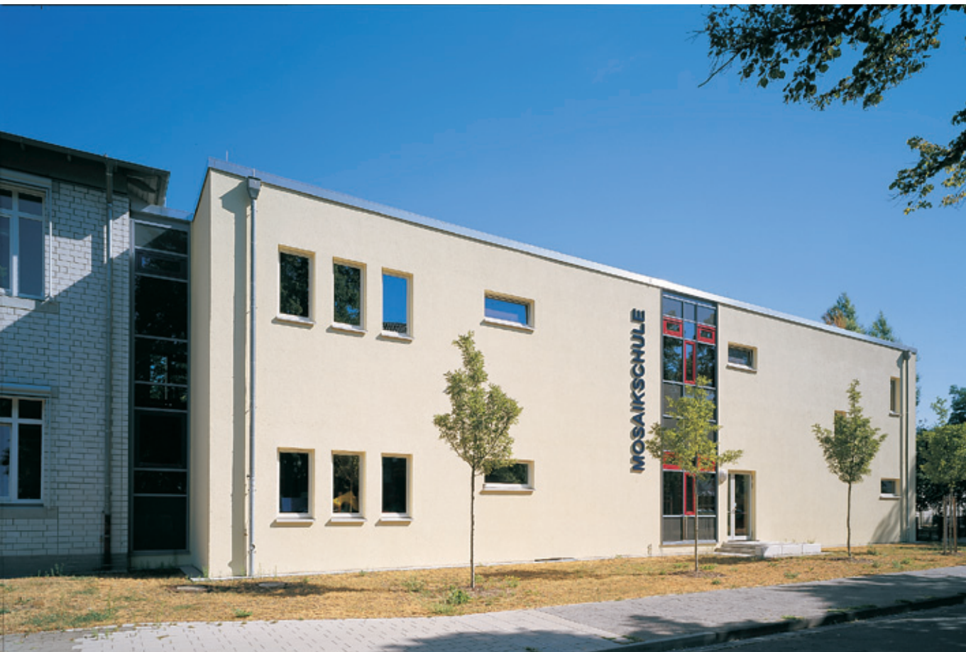
Erweiterung der Mosaikschule | Neuenkirchener Straße 43 Stadt Gütersloh | Fachbereich Hochbau
