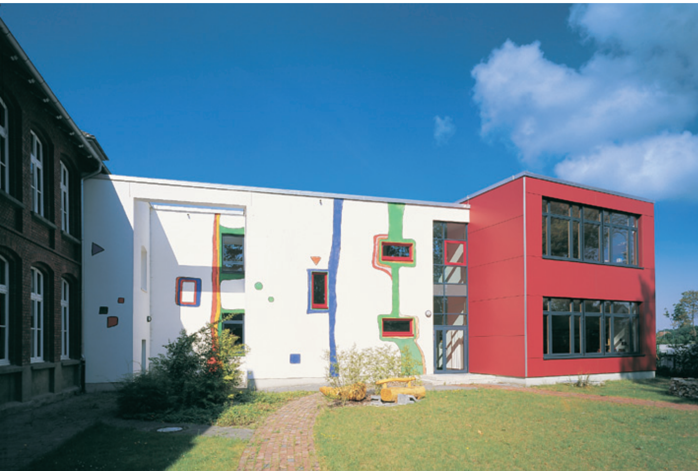
Anbau der Hundertwasserschule | Oststraße 44 Stadt Gütersloh | Fachbereich Hochbau
