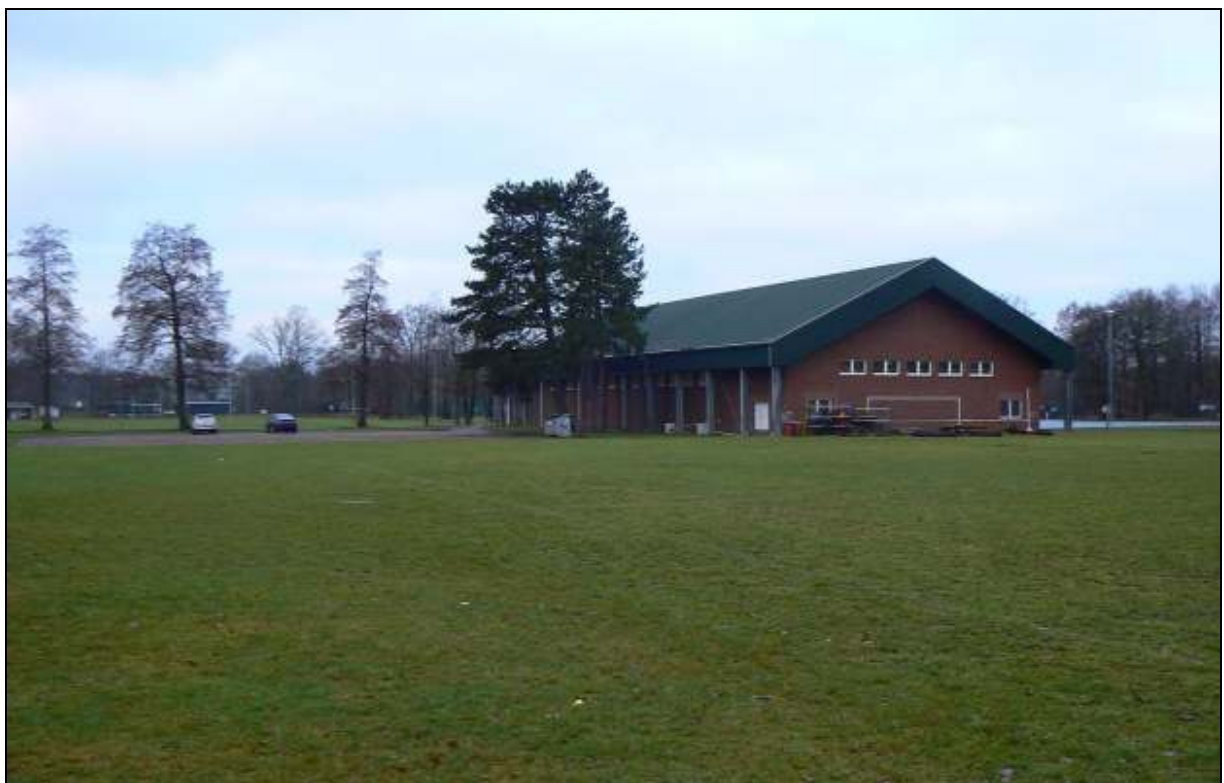
Abbildung 22: Foto Kaserne – Sportanlage im nördlichen Teilbereich –
