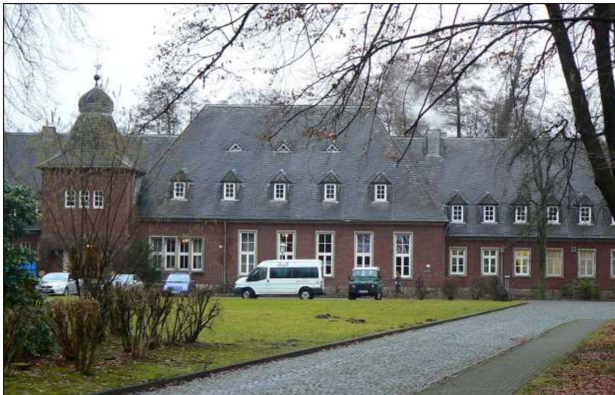
Abbildung 19: Foto Kaserne – Offizierskasino –
