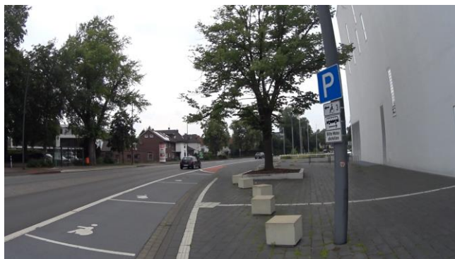
Bild 12: Überleitung Seitenraum auf Radfahrstreifen am Theater
