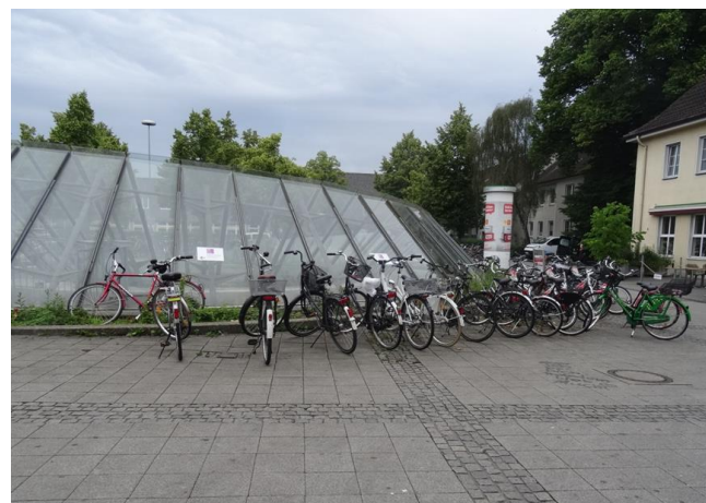
Bild 24: Zufahrt Fahrradparkhaus und abgestellte Fahrräder ohne Abstellanlagen auf dem Bahnhofsvorplatz
