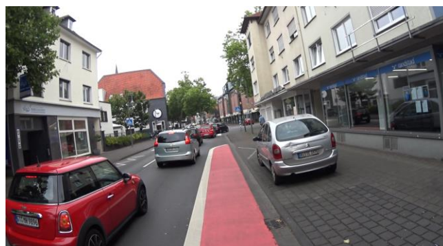
Bild 15: Überleitung Radfahrstreifen in Seitenraum auf Blessenstätte vor abknickender Vorfahrt
