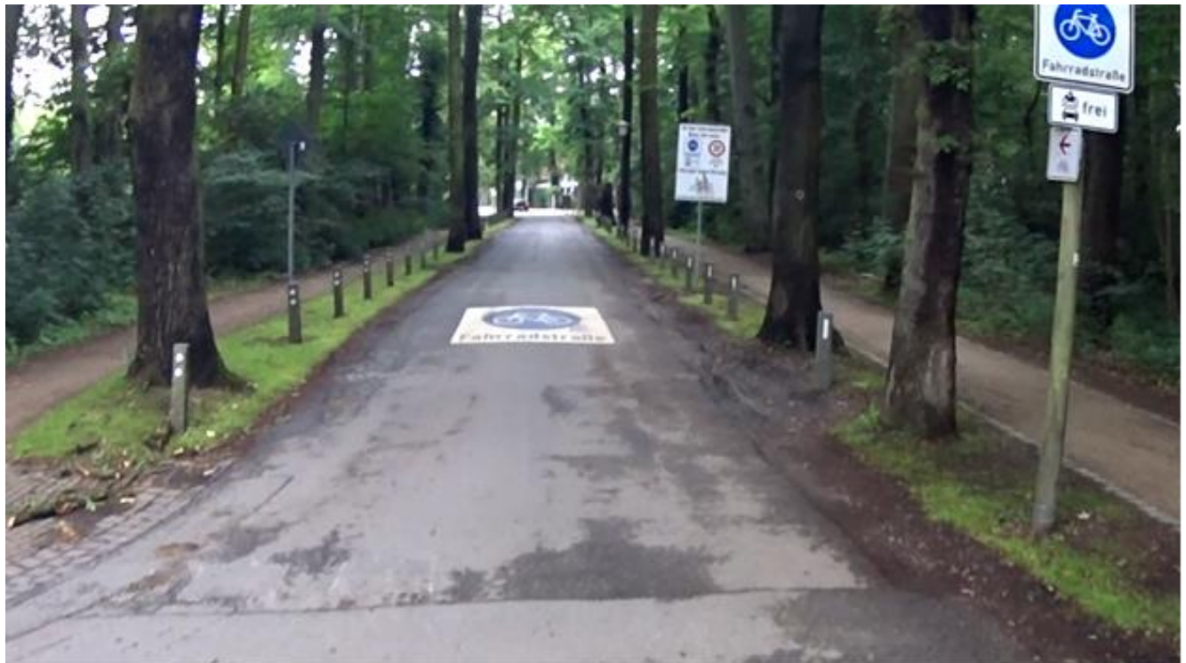
Bild 29: Beginn/Ende Fahrradstraße Parkstraße/Dalkestraße in Fahrtrichtung Norden
