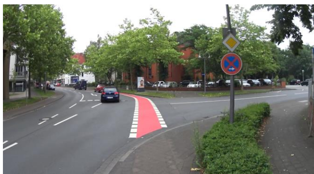
Bild 14: Überleitung Seitenraum auf Radfahrstreifen auf Blessenstätte an der Einmündung Friedhofstraße
