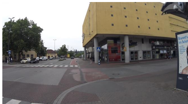
Bild 13: Überleitung Seitenraum auf Radfahrstreifen Kaiserstraße
