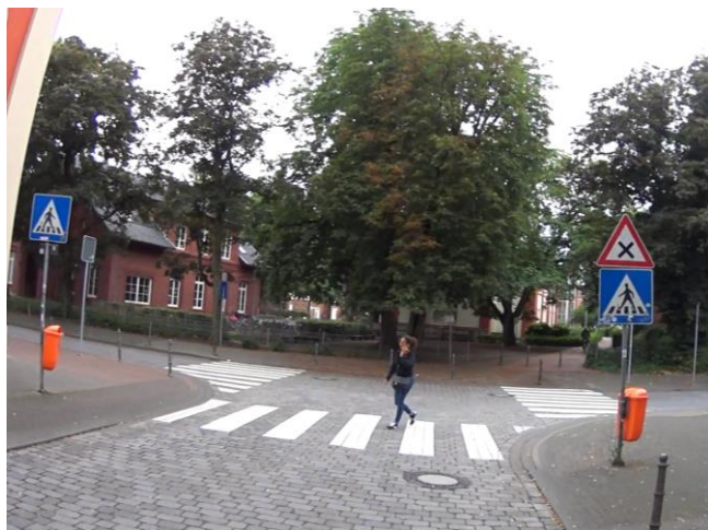
Bild 16: Anbindung gemeinsamer Geh- und Radweg am Knotenpunkt Schulstraße/Moltkestraße
