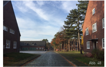
Bestandsfoto Kasernengelände, Panzerhalle Mitte (links) und Mannschaftsunterkunft (rechts)
