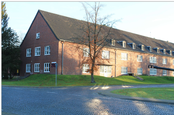
Abb. 50: Kasernengebäude mit Satteldach
