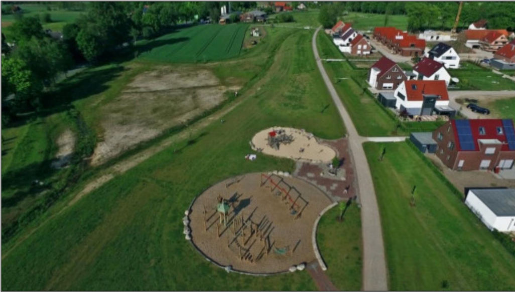
Abbildung 8: Regenrückhaltung und Versickerung Wohngebiet „Krullsbachau“ (Fachbereich Grünflächen)
