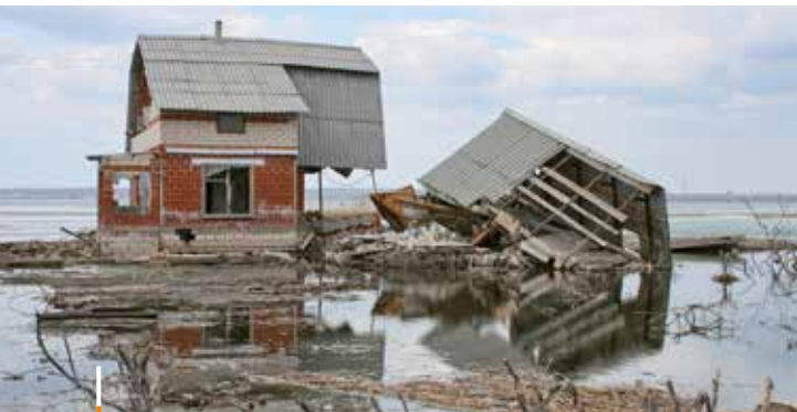
Hochwasser zerstört Häuser und manchmal die seelische Gesundheit der Opfer.
