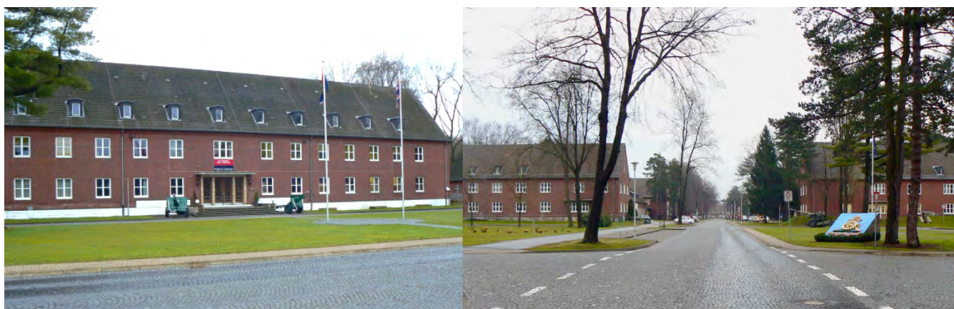
Abb. 16 & 17: Nachrichtenkasernen Hauptgebäude; Zentrale Erschließungsachse (Stadt Gütersloh 2011)
