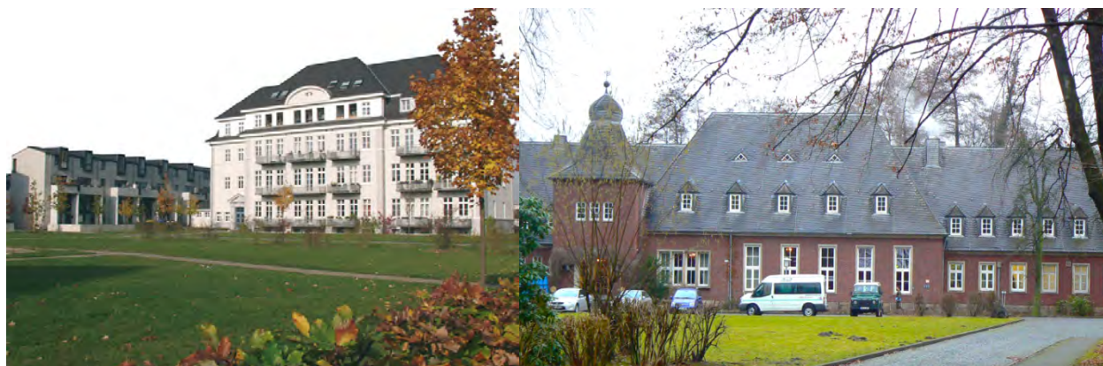
Abb. 18 & 19: Umnutzung der ehemaligen Lincoln-Kaserne in Münster; Das Offizierskasino der Nachrichtenkasernen (Stadt Münster 2008; Stadt Gütersloh 2011: 25)
