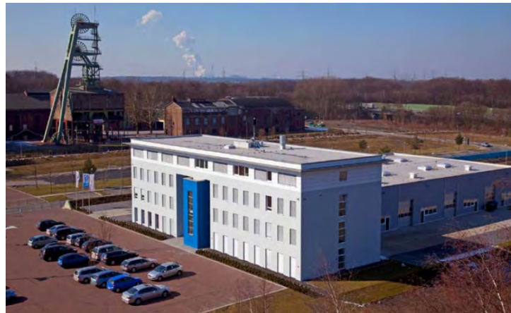
Abb. 25: Wasserstoffkompetenzzentrum auf der Fläche der ehemaligen Zeche Ewald in Herten (Stadt Herten 2011).
