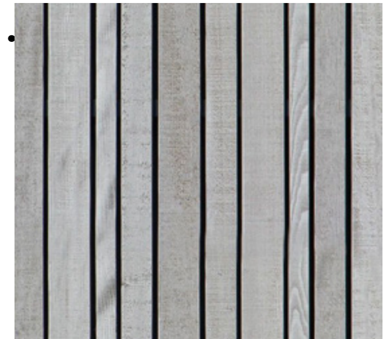
Vertikale Holzfassade Vorhangfassade, Lärchenholz
