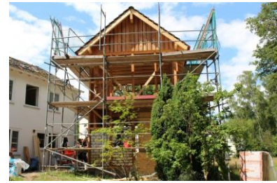
Ansicht des Rohbaus in der Parsevalsiedlung
